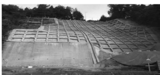
コンクリート枠による斜面の補強
