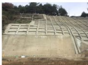
斜面の崩壊防止対策 (コンクリート枠による斜面の補強)
