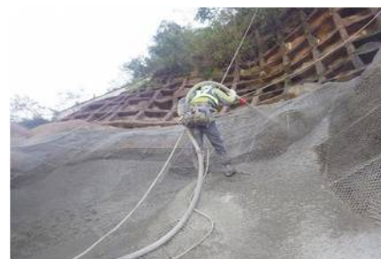
写真4 透水性コンクリート吹付状況
