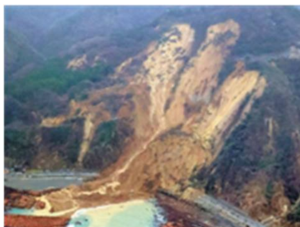
令和6年能登半島地震の崩壊例
