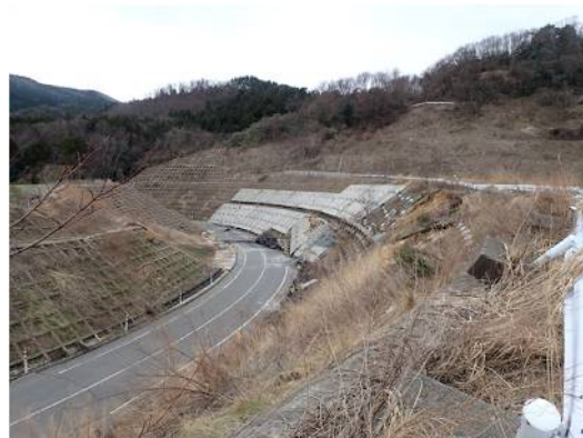
写真1 能登半島地震のアンカーが施工された法面
