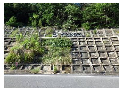
写真8 湧水箇所ののり枠工
