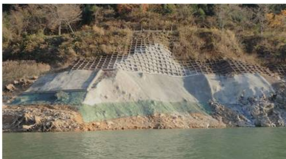
写真5 補修完了全景（施工後）
