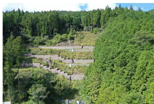
写真 2 調査対象法面
