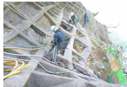
写真3 既設吹付枠工の取り壊し状況
