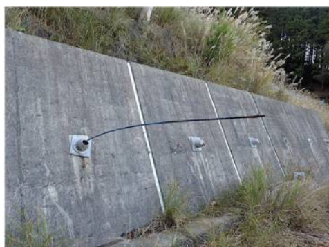
写真 3 アンカーの状況
