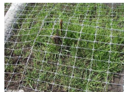
写真6 金網を浮かせて設置
