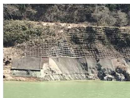
写真6 施工後7年経過全景
